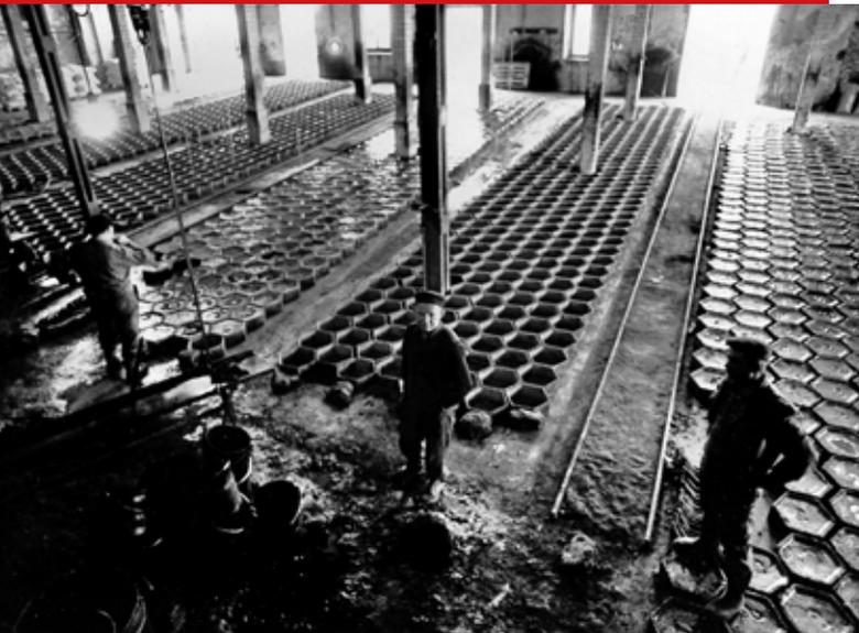
Chauffé, l'asphalte est coulé dans des moules pour assurer son transport. *gout-region.ch*.
